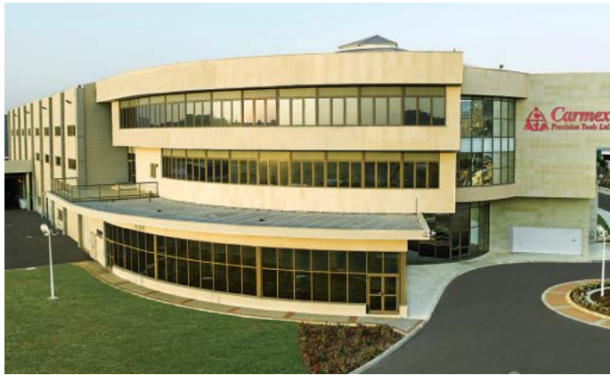
2008年8月竣工のカーメックス社新工場(イスラエル、マーロット)
